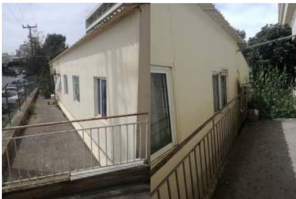
εικ. 4,5: Ανατολική και δυτική όψη κτιρίου Αιμοδοσίας. Διακρίνεται η ράμπα σύνδεσης με το κεντρικό κτίριο που χρήζει βελτιώσεων, ιδιαίτερα στην κλίση που διαθέτει.
